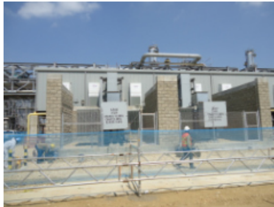
Figura 2. Subestación media tensión tipo exterior
