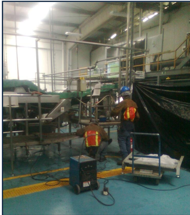
Figura 15 Modificación de banda transportadora de banano en Planta de Gerber
