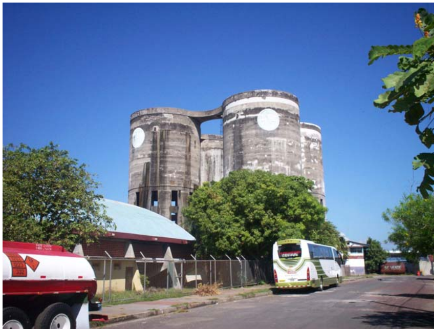
Ilustración 3. Tanques de almacenamiento en Los Caites, Puntarenas Fuente: Autor. 14-05-2009
