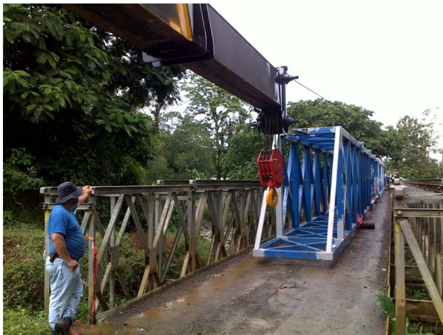
Ilustración 5. Traslado de la estructura hasta los pedestales Fuente: Autor. 30-11-2010
