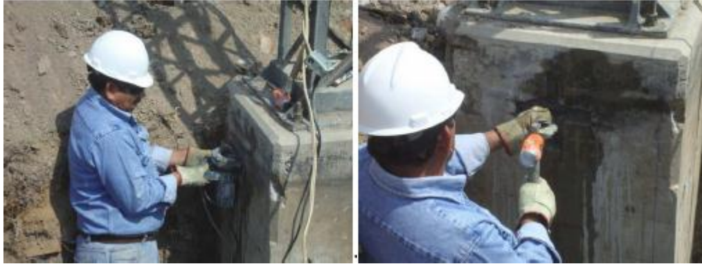
Figura 19. Calas para verificar el estado del acero
