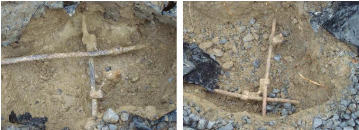
Figura 17. Evaluación del sistema de tierra física de la subestación
