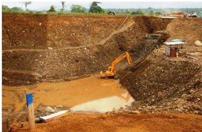
Movimiento de tierras casa de máquinas
