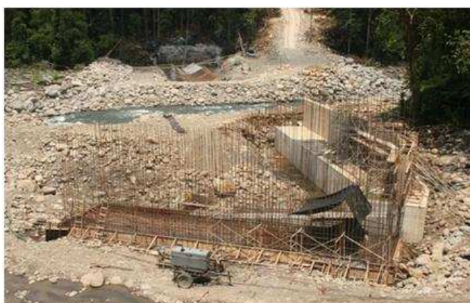
Trabajos presa y toma de agua
